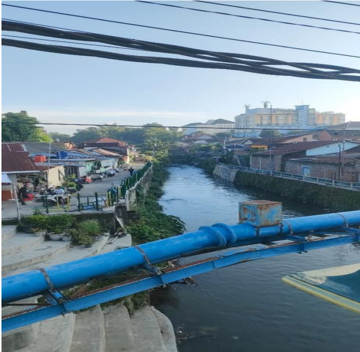
Gambar.1. Model penahan erosi di sempadan sungai di DIY dengan metode bangunan sipil teknis
